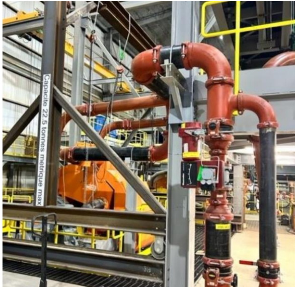
WHIMS à revêtement en caoutchouc (à gauche) ; vannes (à droite).
