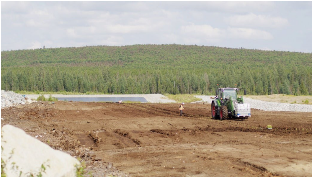
Figure 1 : Travaux de plantation des saules sur le site de LAN
