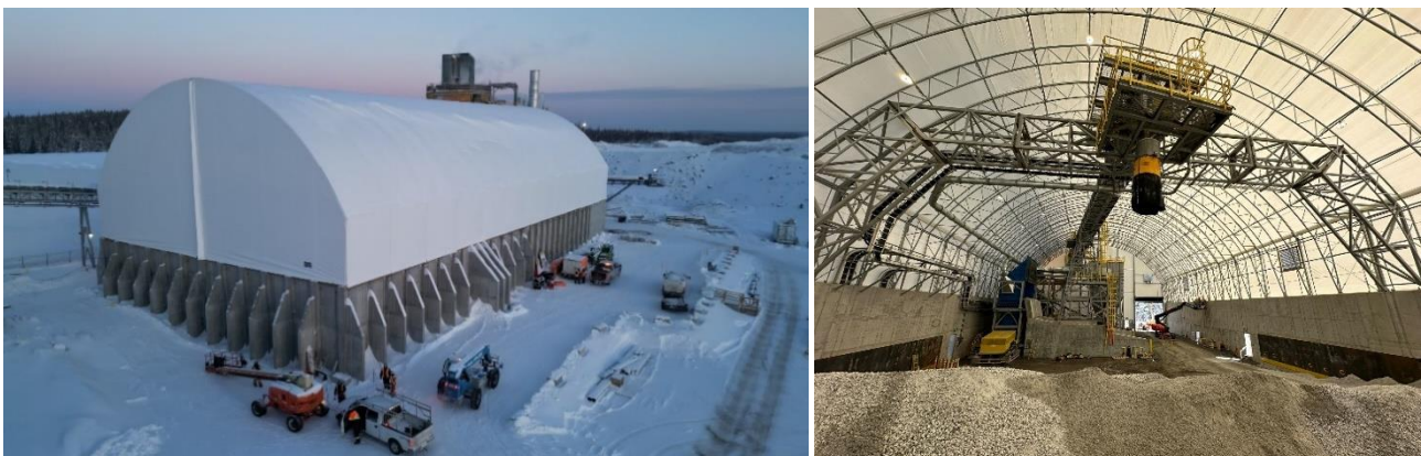
Figures 4 and 5: Les étapes finales dans la construction du dôme de minerai concassé
